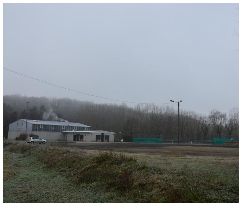
Espace du Foyer Rural
